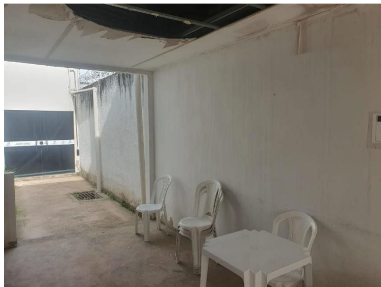
Figura 5.1 – Local designado para instalação do inversor.
