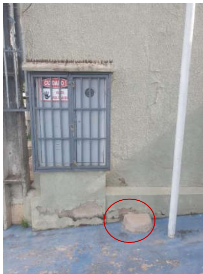
Figura 8.1 – Ponto de conexão à rede do inversor trifásico
