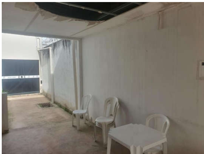
Figura 5.1 – Local designado para instalação do inversor.
